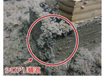
薬剤無塗布の試験体 (蟻道の形成あり)
