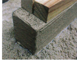
CTバリヤー塗布の試験体 (蟻道の形成なし)
