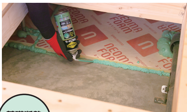
基礎断熱の隙間に
